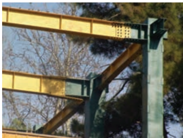
شکل ۳-۴- اتصال پیچی در سازه فلزی ساختمان
