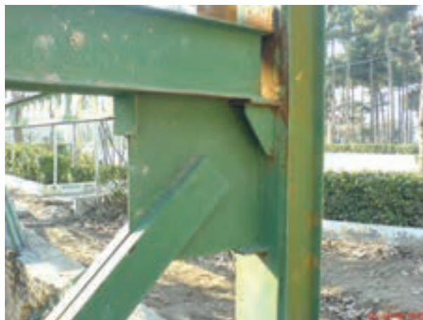
شکل ۳-۲- اتصال جوشی در سازه فلزی ساختمان
