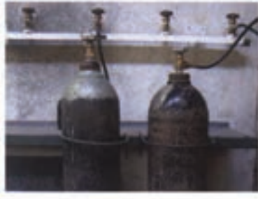
اتصال کپسول اکسیژن به خط لوله
