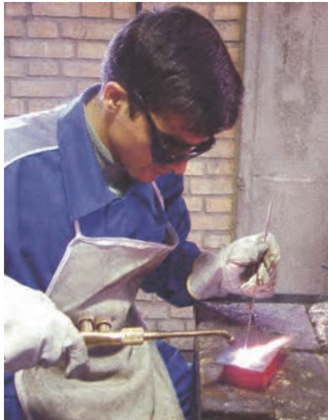
شکل ۸-۴۱ جوشکار در حال جوشکاری با سیم جوش
