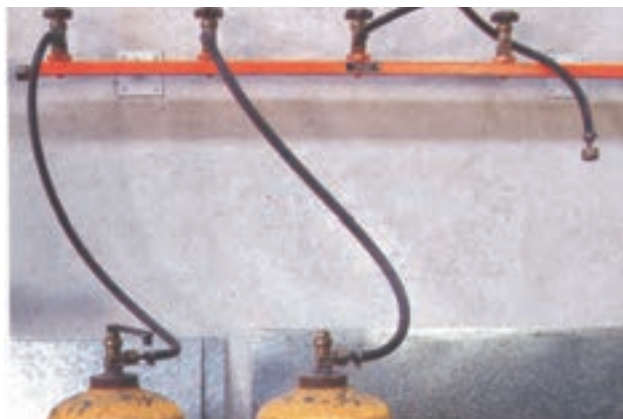
شکل ۱۹-۲ پست مرکزی استیلن
