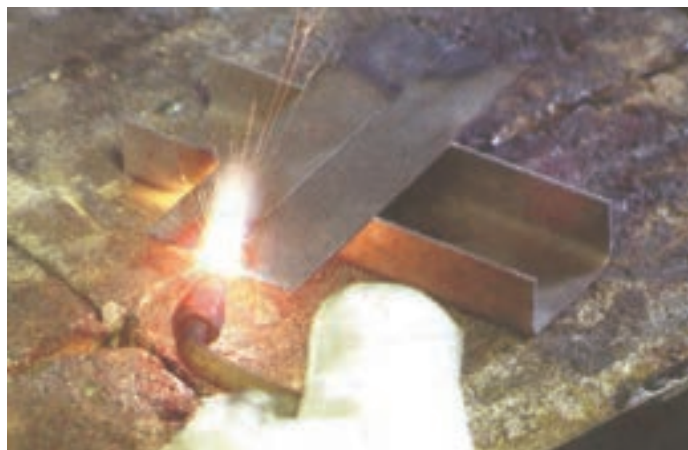
شکل ۸-۴۸-۱ خال جوش زدن در طرفین اتصال
