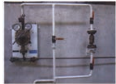
لوله کشی پست مرکزی گاز اکسیژن
