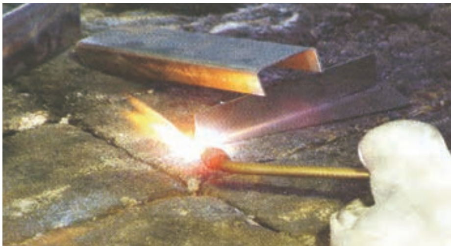
شکل ۸-۲۹ نحوه خال جوش زدن با استفاده از قطعه کمکی
