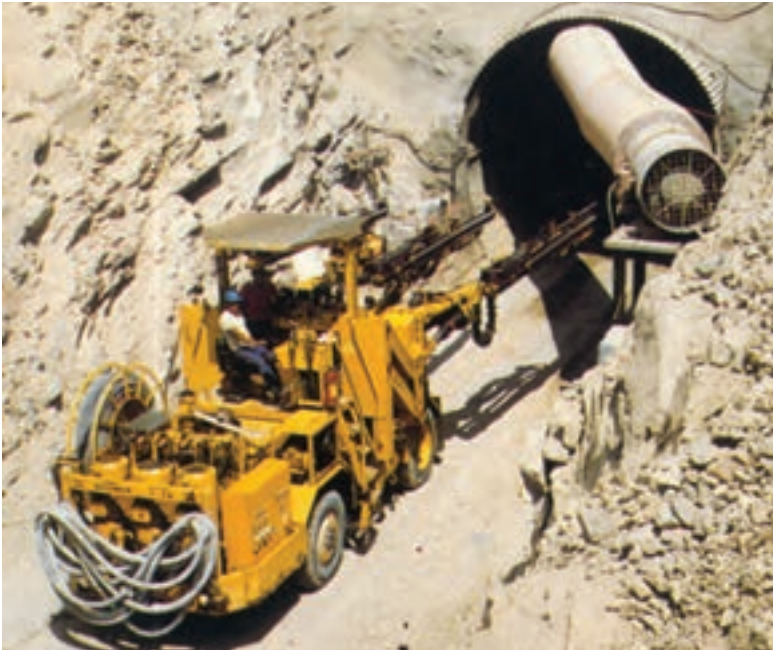
شکل ۵-۶- تونل اصلی ورودی یک معدن
