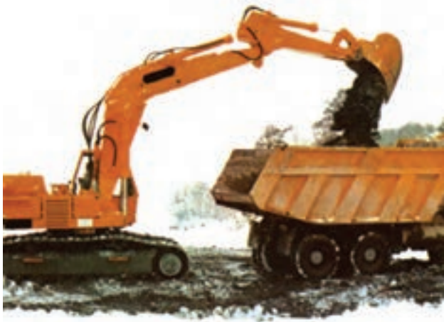
شکل ۲۳-۴- کج بیل در حال حفر کانال
