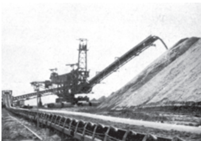
شکل ۳۱-۲ جابه‌جایی باطله توسط نوار نقاله
