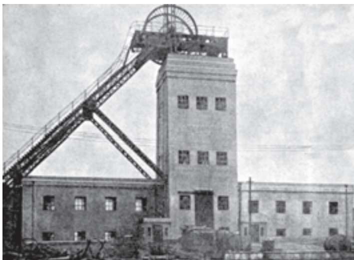
شکل ۱۴-۱- تأسیسات بیرونی آسانسور چاه معدن
