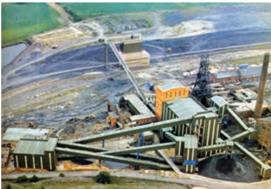
شکل ۱۰-۲- تأسیسات سطحی یک معدن روباز
