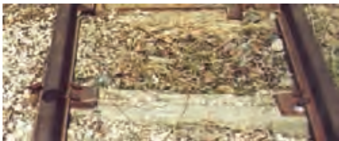
شکل ۳-۳۱- اتصال ریل به تراورس چوبی
