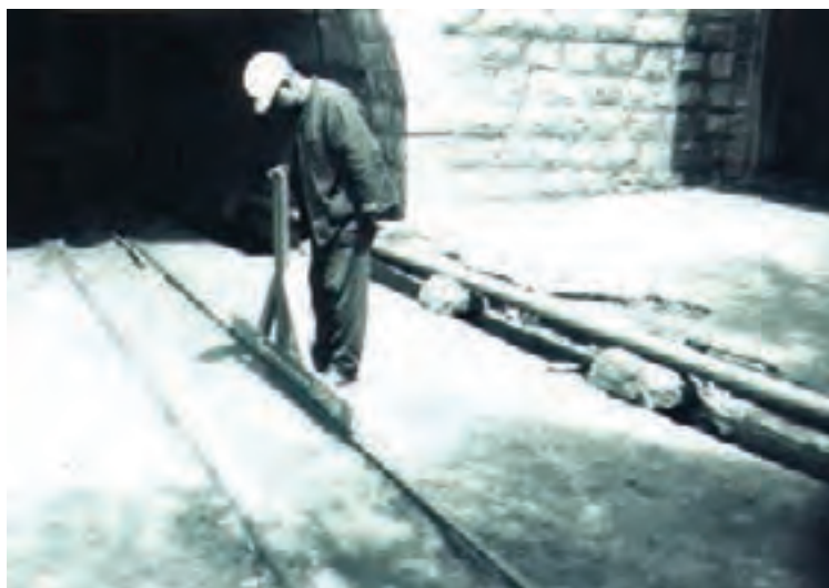
شکل ۸-۳۱- کارگر در حال اجرای روش واترپاس
