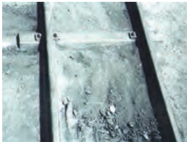
شکل ۴-۳۱ اتصال ریل به تراورس فلزی
