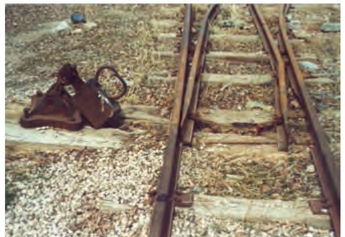
شکل ۱۱- ۳۱- انواع خطگردان و انشعاب خطوط ریل
