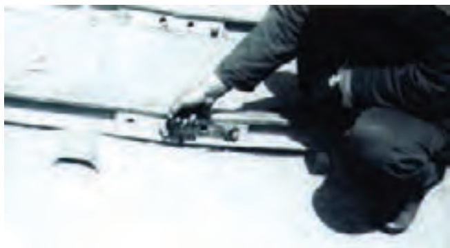
شکل ۵-۳۱ کارگر در حال بستن بغل‌بند
