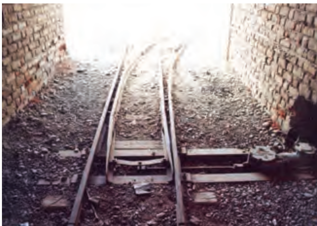
شکل ۱۱- ۳۱- انواع خطگردان و انشعاب خطوط ریل
