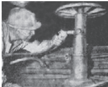
شکل ۳- ۲۷- پایه‌ی هیدرولیکی
