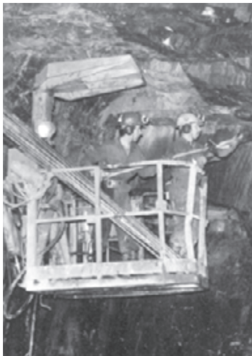
شکل ۲-۲۸- طریقه‌ی نصب پیچ سنگ
