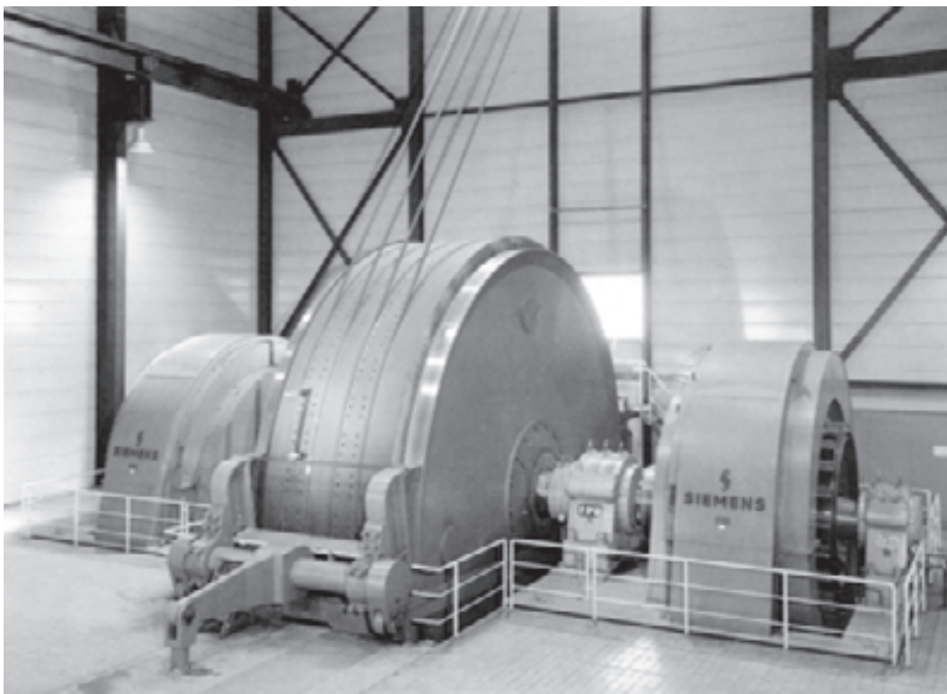
شکل ۱۳-۱۴ - ساختمان مخصوص جرثقیل [۱۳]
