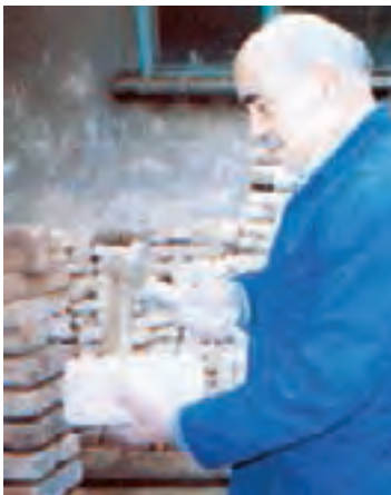
شکستن آجر به روش غلط
