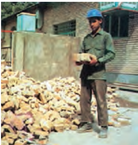
شکل ۱۲-۱۹- طریقه‌ی برداشتن و به دست گرفتن چند آجر
