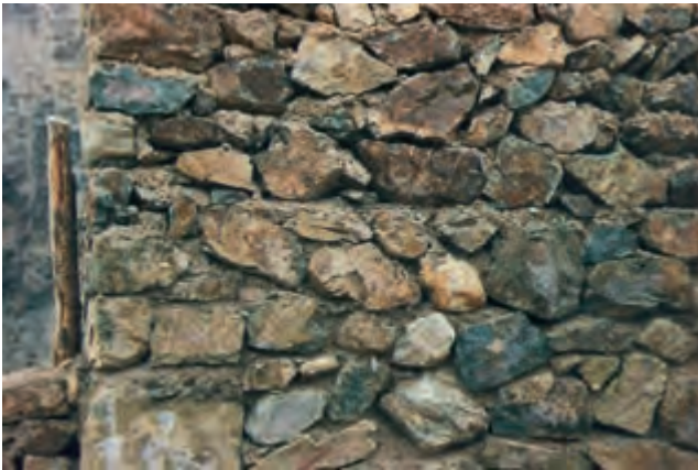
شکل ۶-۲- نمایش دیوار لاشه چینی با ملات
