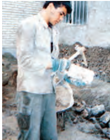
شکستن آجر به روش درست
