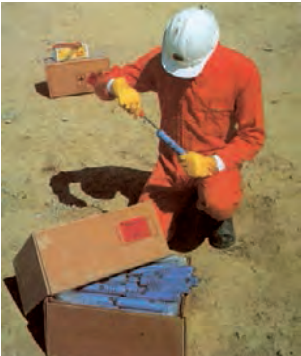
شکل ۹-۱۶- نحوه سوراخ نمودن دینامیت با درفش
