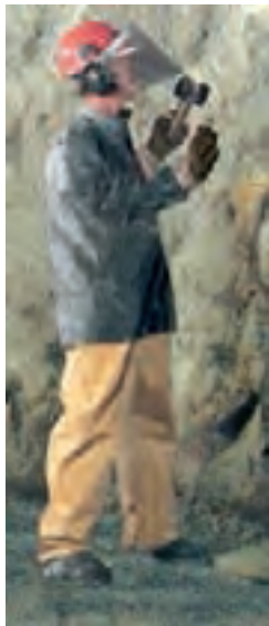
شکل ۵-۱۷- بازرسی سقف از طریق لرزش
