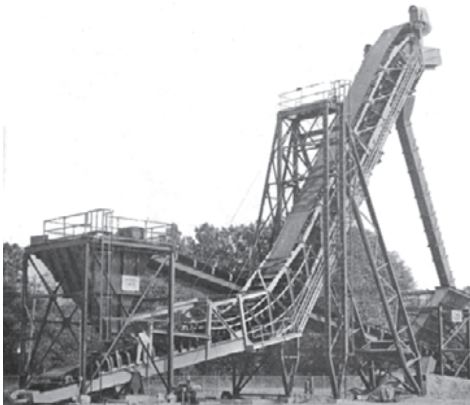
شکل ۱۱-۱۷- نوار باربری پرشیب
