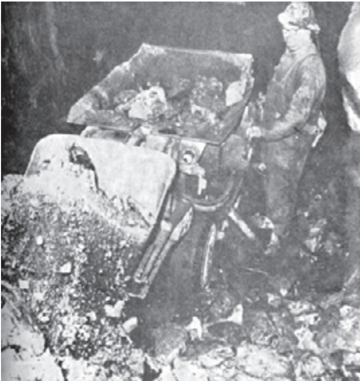
شکل ۱-۲- طرز کار بارکننده مکانیکی
