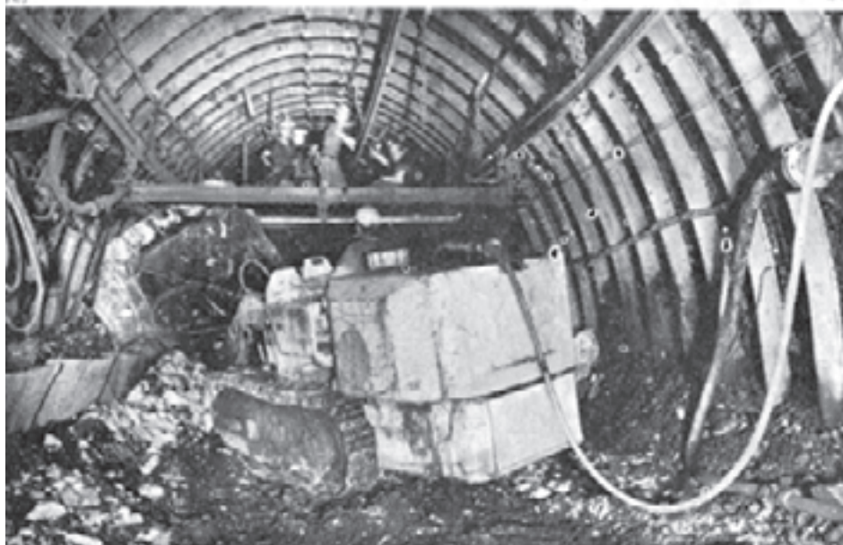
شکل ۱۰-۳ نحوه کار بارکننده در تونل
