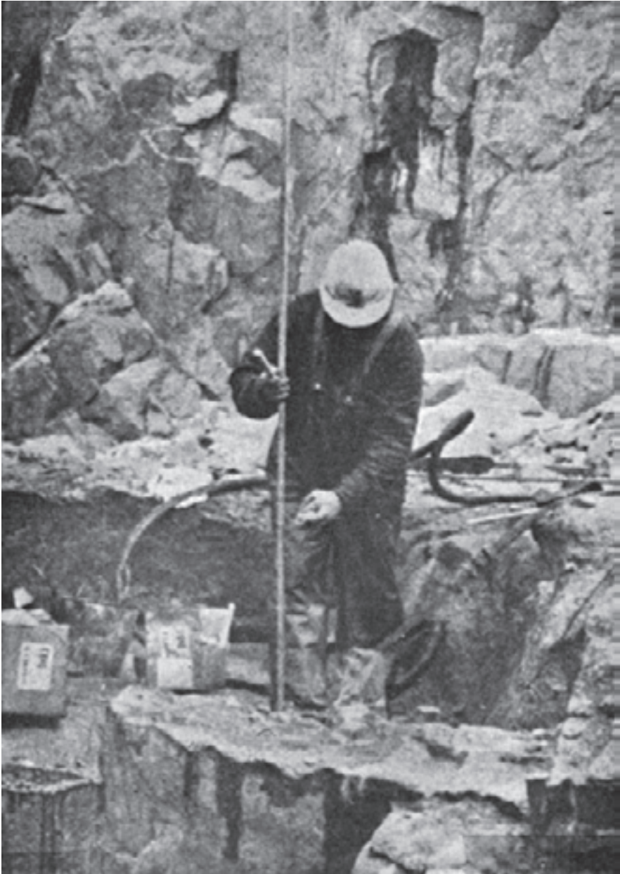
شکل ۱-۷- خرج گذاری با سنبه چوبی در معادن روباز
