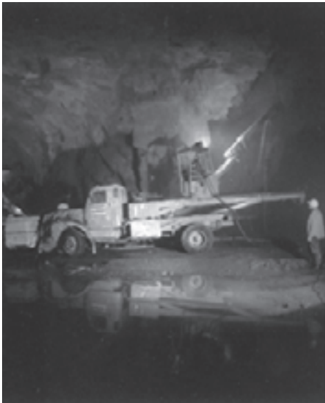
شکل ۷-۳۲- ایجاد یک لایه بتن با سیستم شاتکریت
