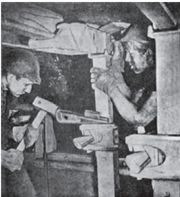
شکل ۹-۸ - نحوه نصب پایه‌های فلزی
