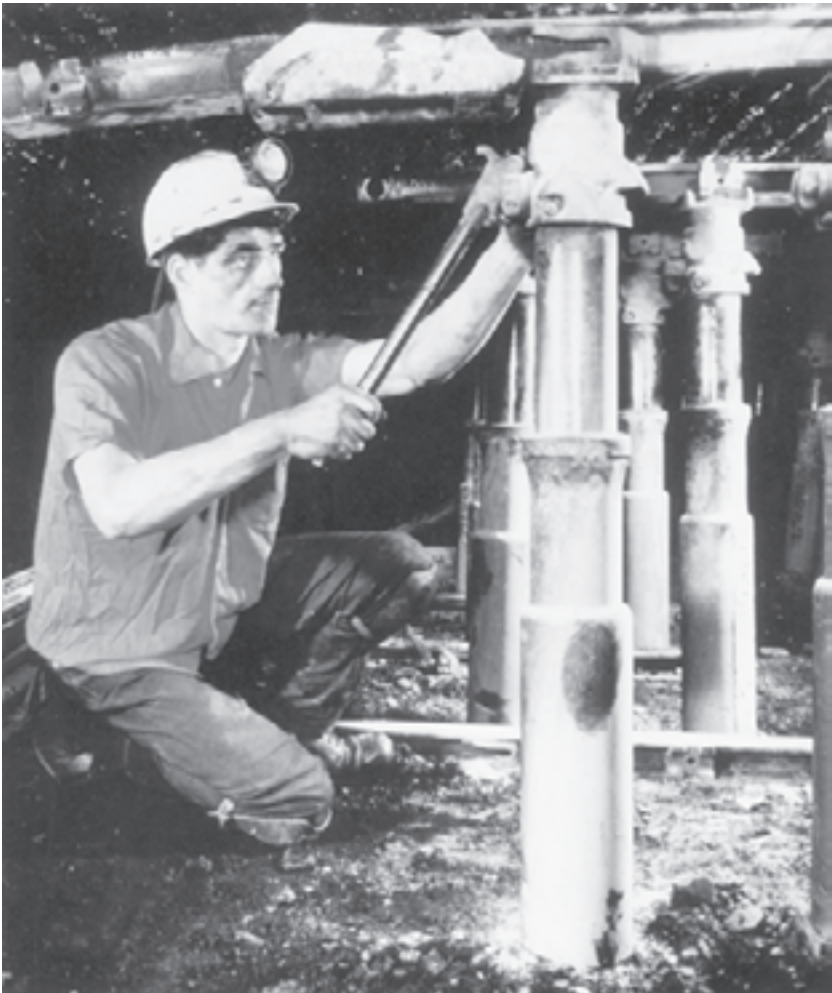
شکل ۹-۱۰- نصب پایه‌های هیدرولیکی در کارگاه استخراج
