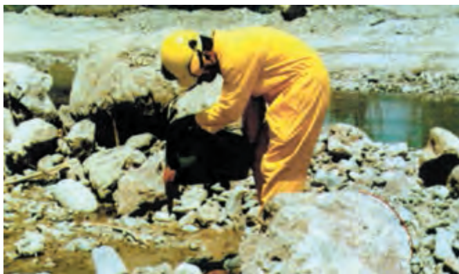
شکل ۲۸-۶- نحوه پرکردن جال‌های انفجاری با اسلاری
