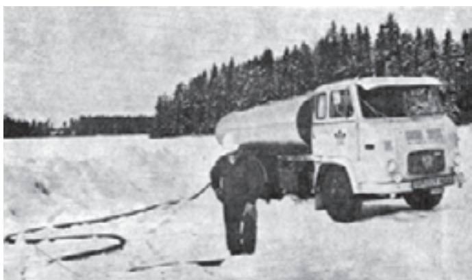
شکل ۱۵-۶- پمپاژ رثولیت به داخل چال
