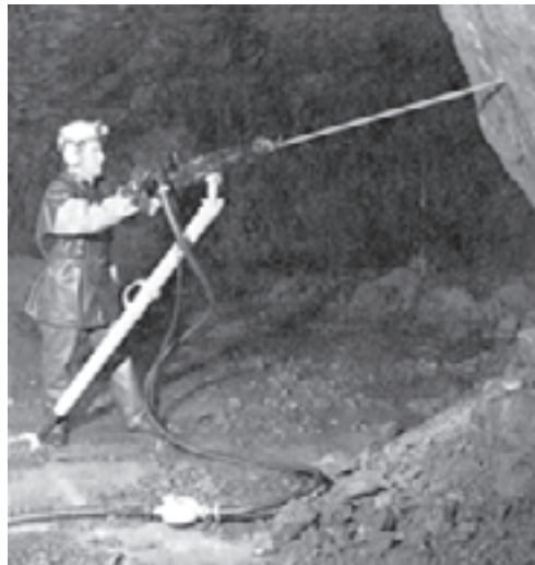
شکل ۲-۷- انواع پایه‌ی انفرادی پنوماتیکی و نحوه‌ی کارکرد با آن
