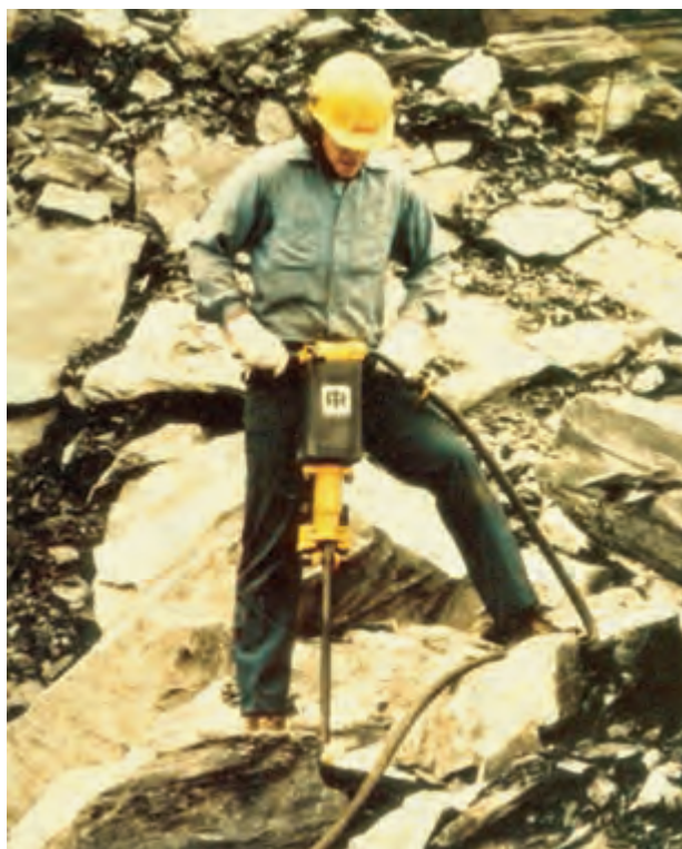
شکل ۵۳-۳- نحوه‌ی پیکور کاری
