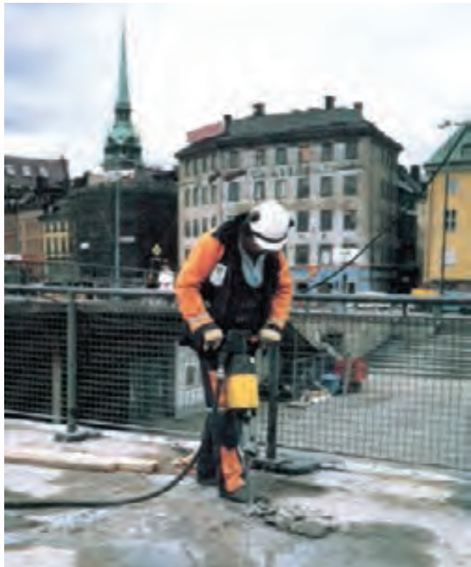
شکل ۳۸-۳- نحوه‌ی کار با انواع پیکور
