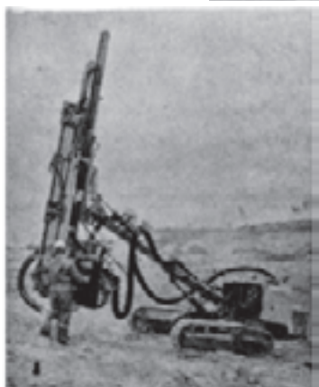
ه - واگن دریل 500S ساخت تامراک در حال حفر چال
