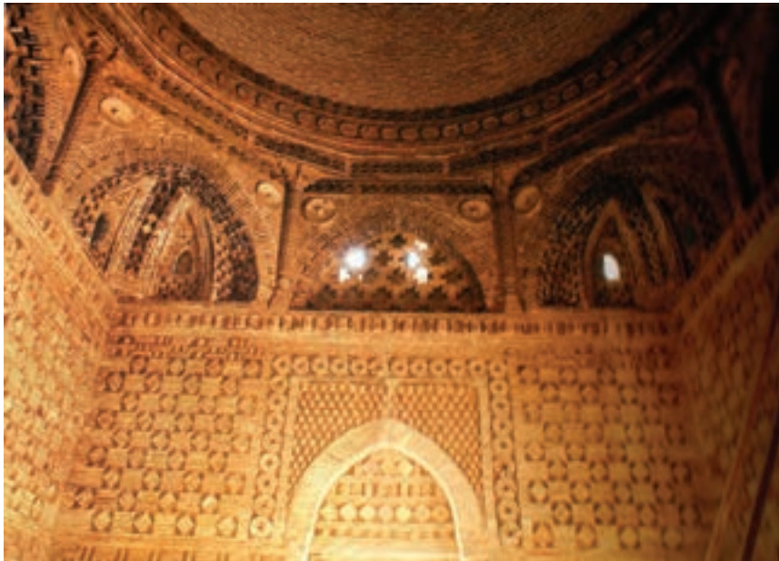
▲ شکل ۸-۳ - طرح آجرکاری، نمای داخلی آرامگاه امیر اسماعیل سامانی، بخارا
