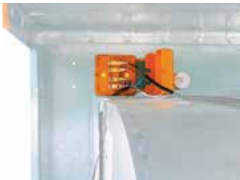
شکل ۱۲-۱۱- جعبه اتصال الکتریکی کولر
