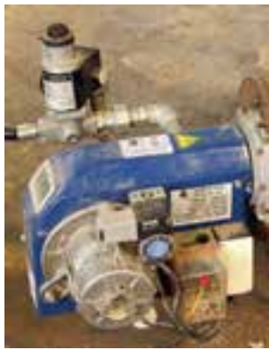
شکل ۹-۸: دستگاه دمنده (ونتیلاتور)
