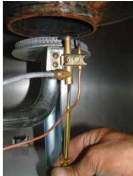
شکل ۱۳-۱۳- تنظیم شعله ی پیلوت
