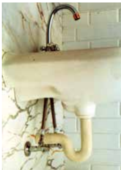
شکل ۳۱-۱۰- نصب دست شویی
