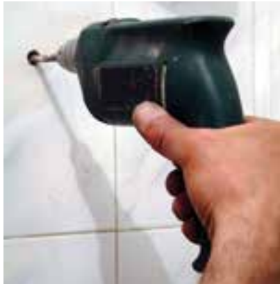
۲- سوراخ کردن محل پیچ‌های روکارا
