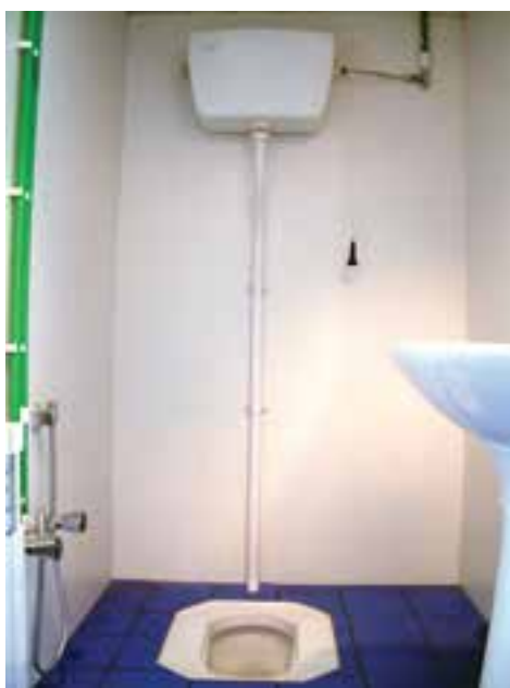
شکل ۳۸-۱۰- اتصال مخزن فشاری به کاسه توالت ایرانی
