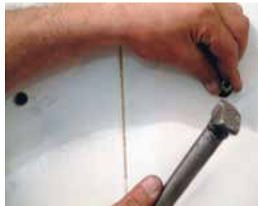
۳- کوبیدن رول‌پلاک در درون سوراخ‌ها
