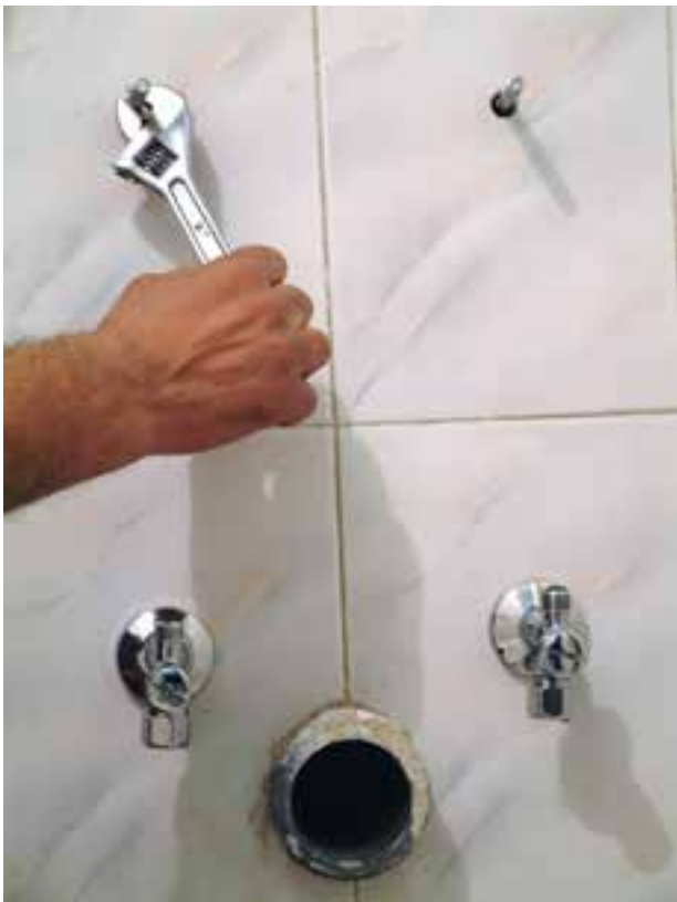
۵- سفت کردن پیچ‌های روکارا در درون رول‌پلاک به وسیله‌ی آچار فرانسه
