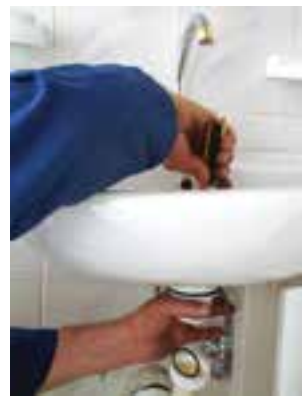
۱- بستن زیراب دست‌شویی به وسیله‌ی پیچ‌گوشتی
