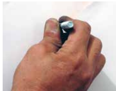
۴- قرار دادن پیچ روکارا در درون رول‌پلاک
