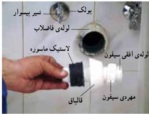
۲- عبور دادن لوله‌ی سیفون افقی از درون مهره‌ی سیفون، قالباق و لاستیک ماسوره
