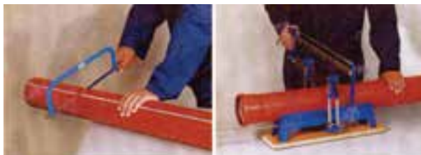
شکل ۱۲-۶- در مواردی که نیاز به برش باشد لوله با زاویه ی صحیح بریده می شود.
