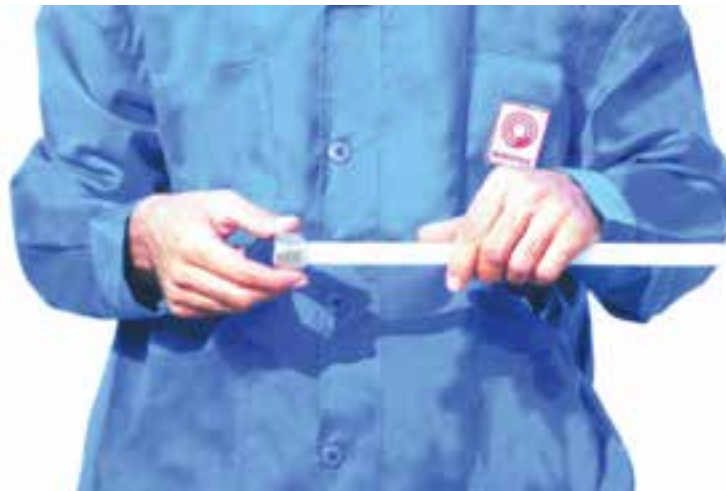
شکل ۱۵-۳- نحوه‌ی جا زدن مهره ماسوره
