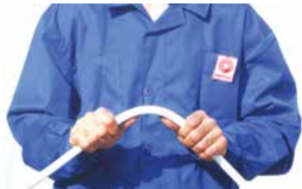
شکل ۸-۳- نحوه‌ی خم کردن لوله با دست و فنر
