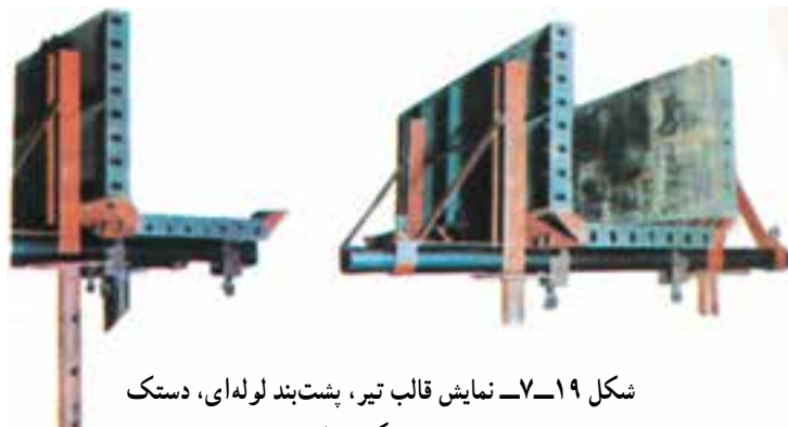
شکل ۷-۱۸- نمایش دستک تیر بر روی پشت‌بند لوله‌ای
