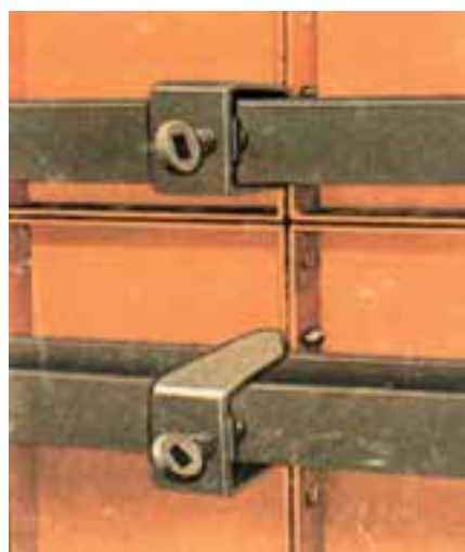
شکل ۱۰-۷- اتصال پشت‌بند ناودانی به بدنه‌ی قالب توسط گیره‌ی بلند
