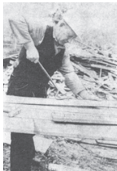
شکل ۱-۳۰ - میخ‌کشی از تخته توسط میخ کش اهرمی
