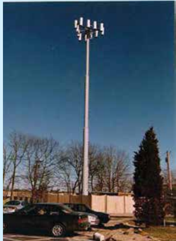
شکل ۹-۱۰۲- ایستگاه BTS و آنتن آن
