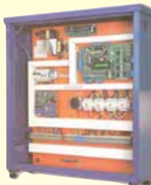
تابلو اصلی برق اضطراری آسانسور
