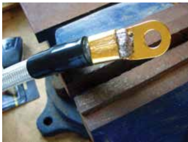
شکل ۳۱-۲- استفاده از گیره ی فلزکاری برای برچ بست در روی کابل
