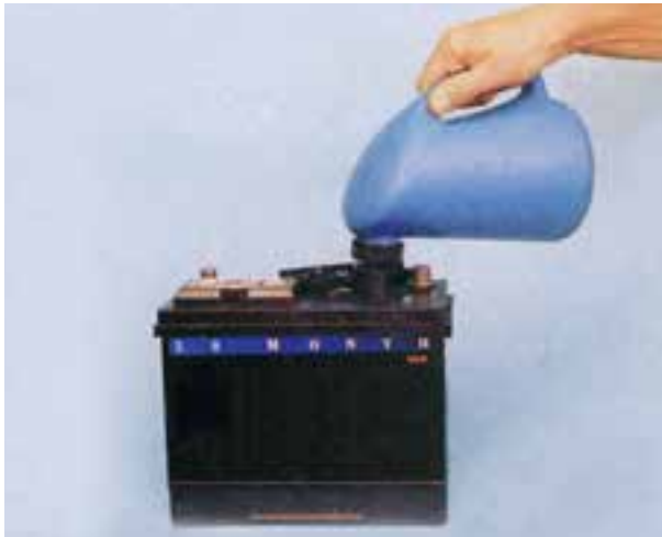
شکل ۱-۲۷ - پر کردن خانه‌های باتری نو با الکترولیت
