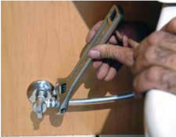
شکل ۳-۲۵۶- سفت کردن مهره‌ی شیر پیسوار
