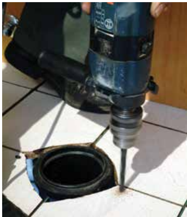
شکل ۲۴۶-۳- سوراخ‌کاری محل‌های علامت‌گذاری شده
