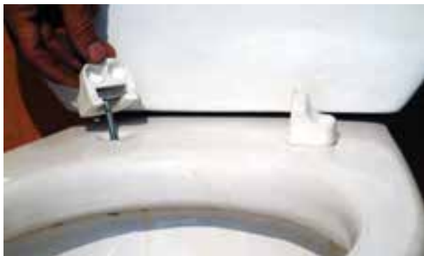
شکل ۳-۲۵۳- اتصال بست‌های نگهدارنده به توالت فرنگی
