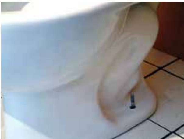
شکل ۲۴۸-۳- قرار دادن توالت فرنگی در محل خود
