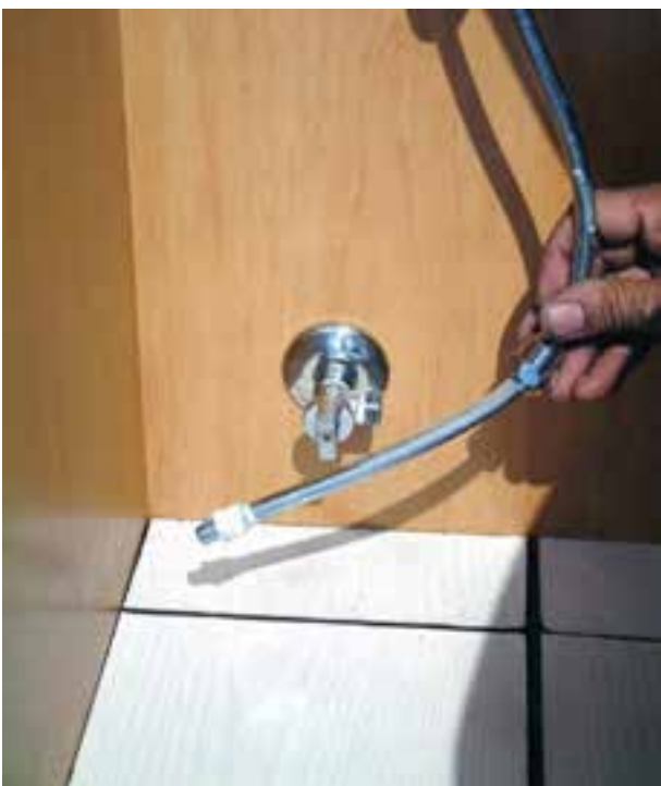
شکل ۳-۲۵۵- خمکاری لوله‌ی پیسوار
