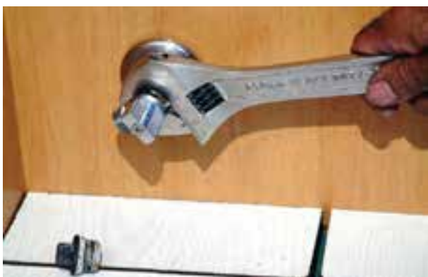
شکل ۳-۲۵۴- سفت کردن شیر پیسوار
