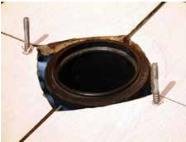
شکل ۲۴۷-۳- بستن پیچ‌های روکا در داخل رولپلاک‌ها
