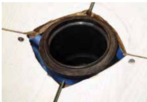
شکل ۲۴۴-۳- قرار دادن بوگیر در داخل زانویی
