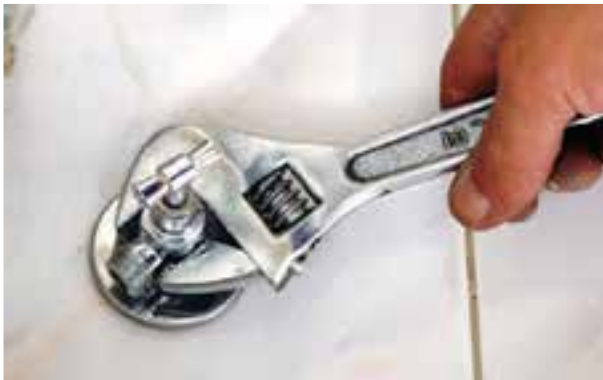
شکل ۲۲۰-۳ سفت کردن شیر پیسوار با آچار فرانسه
