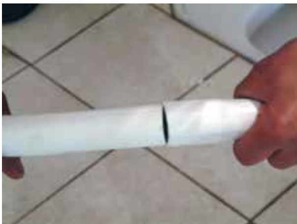
شکل ۳-۲۰۶- جا زدن لوله‌های تخلیه در درون یکدیگر
