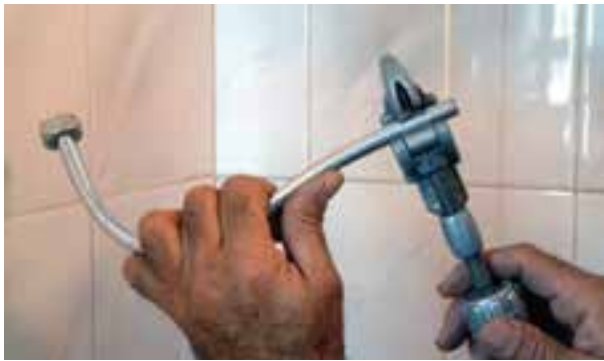
شکل ۲۲۲-۳- بریدن لوله‌ی پیسوار به وسیله‌ی لوله‌بر
