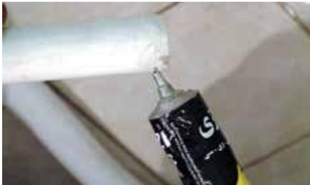
شکل ۳-۲۰۵- زدن چسب به لوله‌های تخلیه
