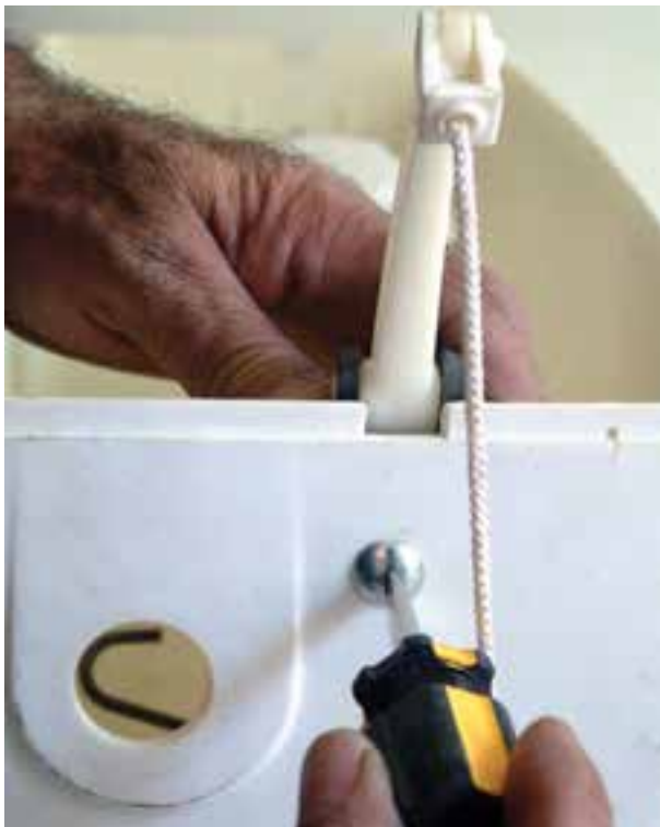
شکل ۳-۲۰۹- اتصال اهرم به بدنه‌ی مخزن فشاری
