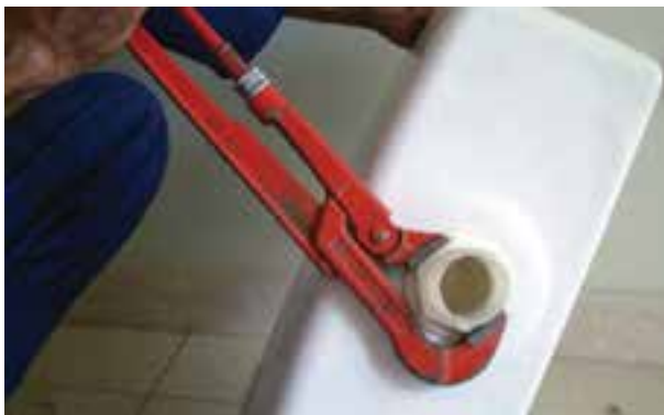
شکل ۳-۲۰۸- سفت کردن مهره‌ی پمپ تخلیه
