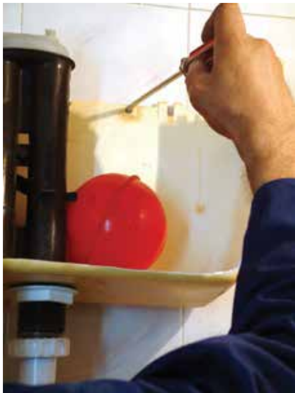
شکل ۲۱۳-۳- نصب مخزن فشاری به دیوار
