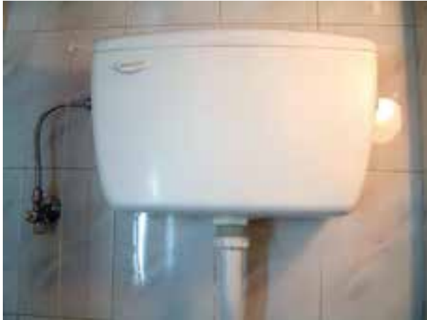
نصب مخزن فشاری
