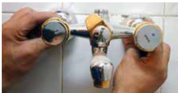
شکل ۲-۲۰۵- بستن مهره‌های شیر مخلوط دوش با دست
