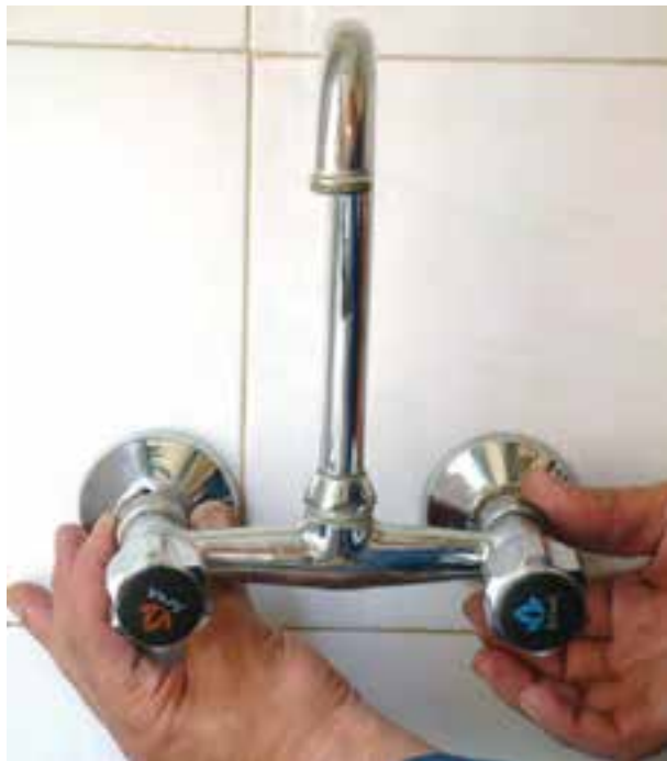
شکل ۱۷۲-۲- پیچیدن مهره‌ها به دنباله‌های شیر مخلوط
