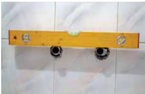
شکل ۲-۱۶۹- کنترل صاف بودن دنباله‌ها
