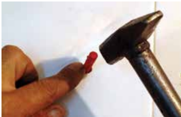
شکل ۱۹۳-۲- کوبیدن رولپلاک درون سوراخ
