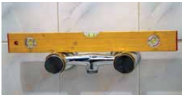
شکل ۱۹۰-۲- سنجش تراز بودن شیر مخلوط
