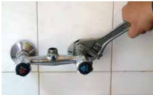
شکل ۱۷۳-۲- سفت کردن مهره‌ها به وسیله‌ی آچارفرانسه
