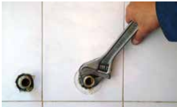
شکل ۲-۲۰۱- سفت کردن دنباله‌ها با آچار
