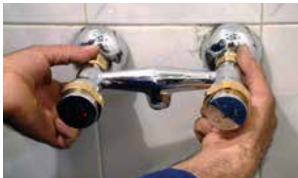
شکل ۲-۱۸۸- اتصال شیر مخلوط توالت به دنباله‌ها
