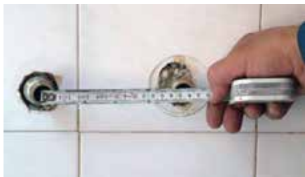
شکل ۲-۲۰۲- کنترل نمودن فاصله‌ی دنباله‌ها به وسیله‌ی متر
