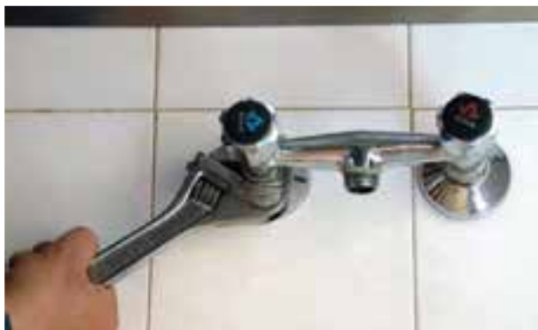
شکل ۱۸۹-۲- سفت کردن مهره‌ها با آچار فرانسه
