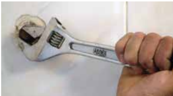
شکل ۲-۱۸۲- بازکردن درپوش‌ها
