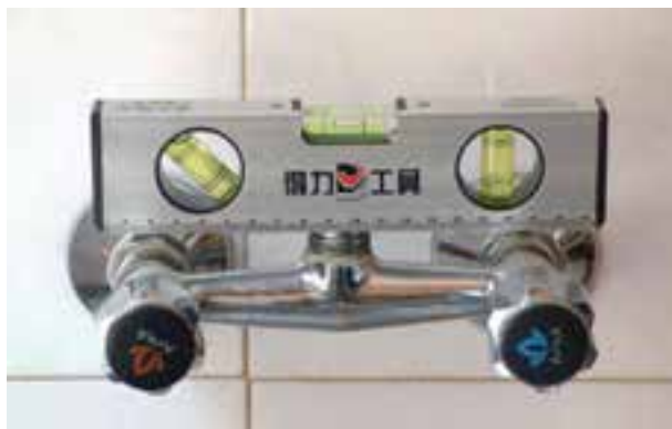
شکل ۱۷۴-۲- سنجش تراز بودن شیرمخلوط دیواری
