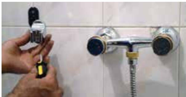
شکل ۱۹۴-۲- نصب بست آویز در محل خود
