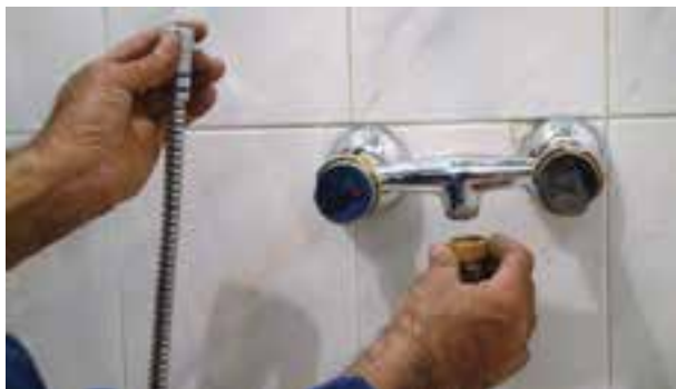
شکل ۱۹۱-۲- اتصال شیلنگ آفتابه به شیر مخلوط توالت
