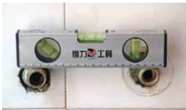
شکل ۲-۲۰۳- کنترل تراز بودن دنباله‌ها
