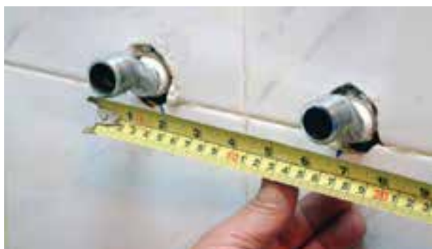
شکل ۱۶۸-۲ کنترل اندازه‌ی محور تا محور دنباله‌ها
