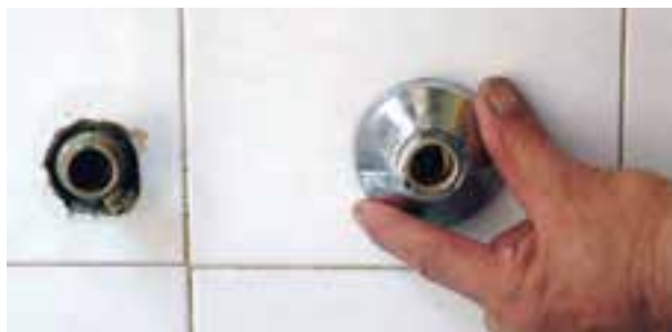
شکل ۲-۱۸۷- اتصال کاسه‌ها به دنباله‌ها
