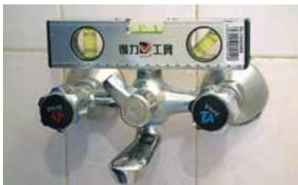
شکل ۲-۲۰۷- سنجش تراز بودن شیر مخلوط دوش
