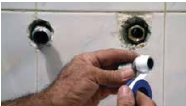
شکل ۲-۱۸۳- بیچیدن نوار تفلون به دنباله‌ها
