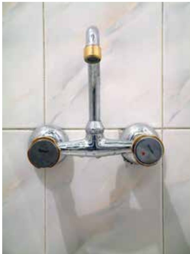
نصب شیر مخلوط دیواری
