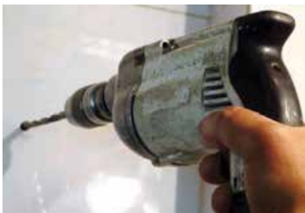
شکل ۱۹۲-۲- سوراخ کردن محل نصب بست آویز
