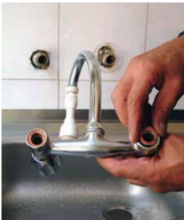
شکل ۲-۱۷۱- قراردادن واشر درون مهره‌ی تنه شیرمخلوط
