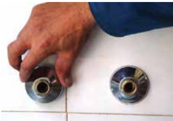
شکل ۲-۱۷۰- بستن کاسه‌ها به دنباله‌ها با دست
