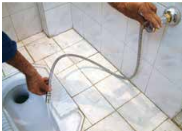
شکل ۱۹۶-۲- عمل هواگیری شیرمخلوط توالت
