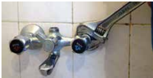
شکل ۲-۲۰۶- سفت کردن مهره‌های شیر با آچار
