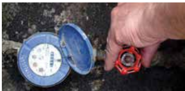
شکل ۱۷۸-۲- باز کردن شیر فلکه‌ی اصلی
