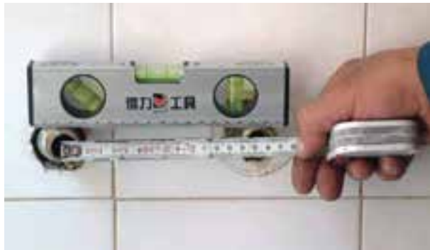
شکل ۲-۱۸۶- کنترل صاف بودن و اندازه‌ی دنباله‌ها
