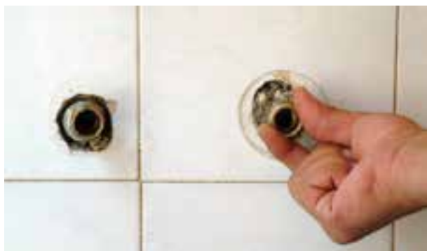
شکل ۲۰۰-۲- بستن دنباله‌ها با دست
