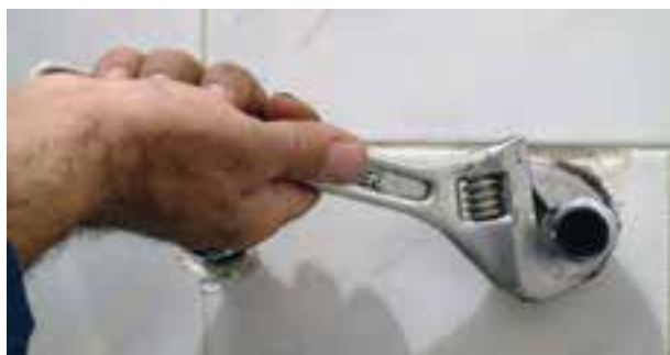
شکل ۱۶۷-۲ سفت کردن دنباله‌ها با آچار فرانسه
