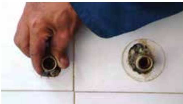
شکل ۲-۱۸۴- بیچیدن دنباله‌ها به محل نصب شیر
