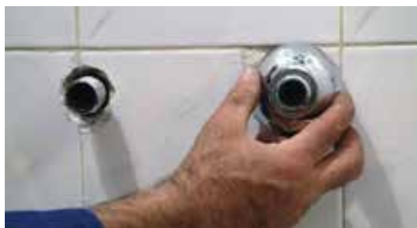
شکل ۲-۲۰۴- پیچیدن کاسه‌ها به دنباله‌ها
