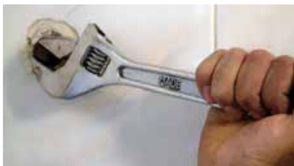
شکل ۱۴۱-۲ بازکردن درپوش
