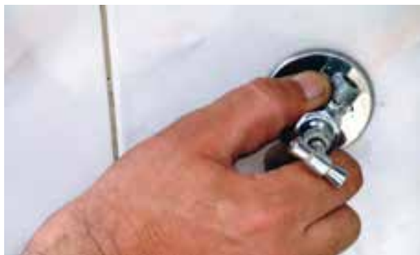
شکل ۱۴۳-۲ پیچیدن شیر پیسوار با دست به محل اتصال
