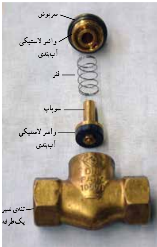
شکل ۲-۱۰۱- اجزای شیر یک طرفه‌ی سوپایی
