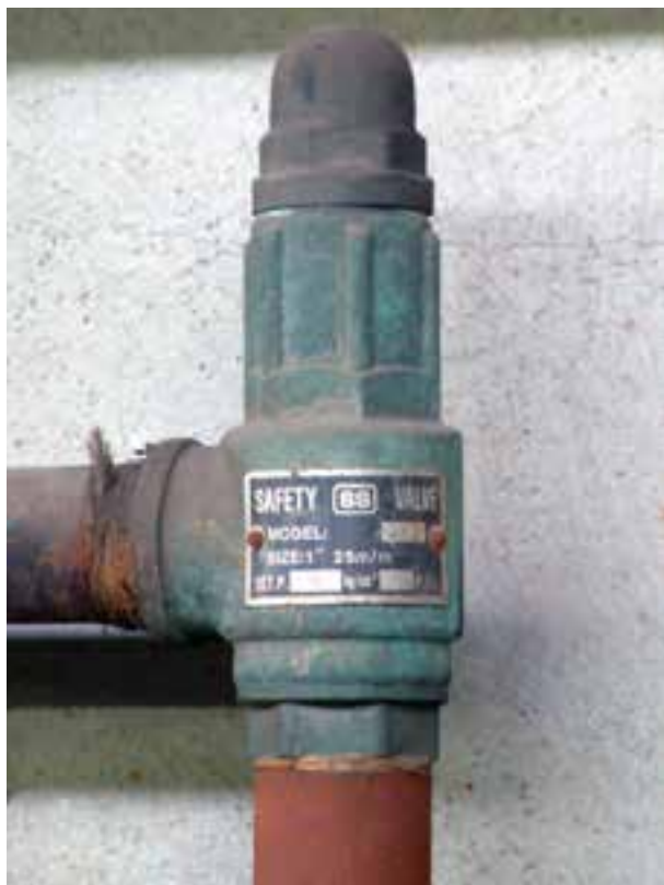
شکل ۲-۱۰۶- شیر اطمینان حساس در برابر فشار
