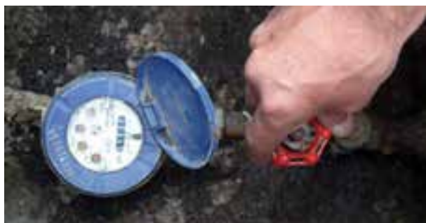
شکل ۱۴۰-۲ بستن شیر فلکه‌ی اصلی
