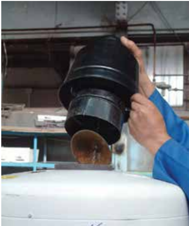
شکل ۱-۱۱۵- برداشتن کلاهک تعدیل از روی دودکش
