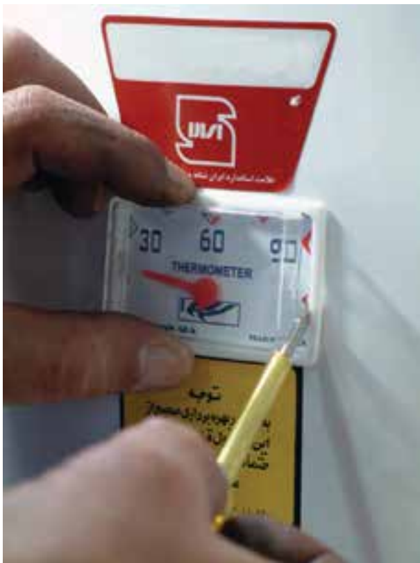
شکل ۱-۱۱۶- جدا کردن ترمومتر
