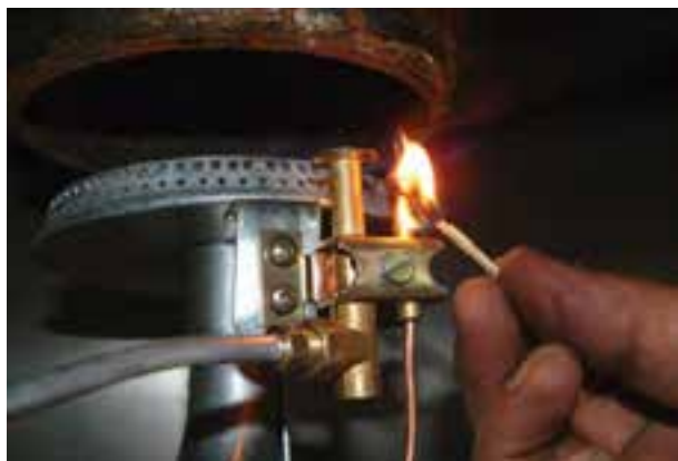
شکل ۱-۱۰۵ مشتعل کردن شمعی به وسیله‌ی شعله‌ی کبریت
