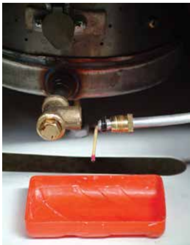
شکل ۱-۵۳- قطع جریان نفت به کوره
