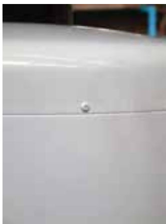
شکل ۱-۳- عدسی روپوش آب گرمکن مخزنی
