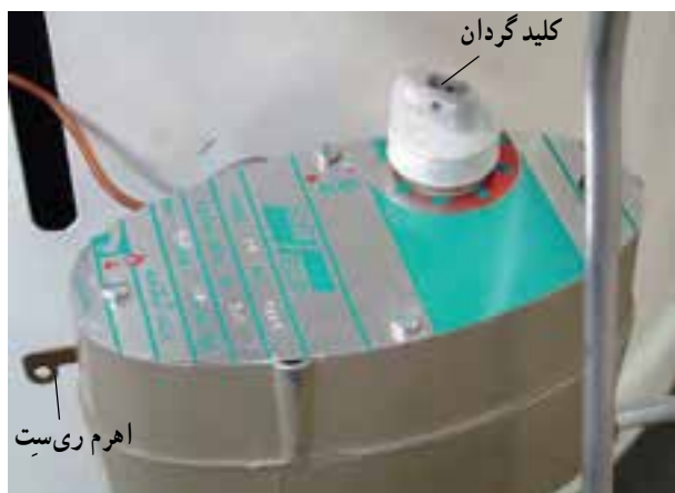
شکل ۱-۳۸- کاربرد اتور آب گرمکن نفت سوز
