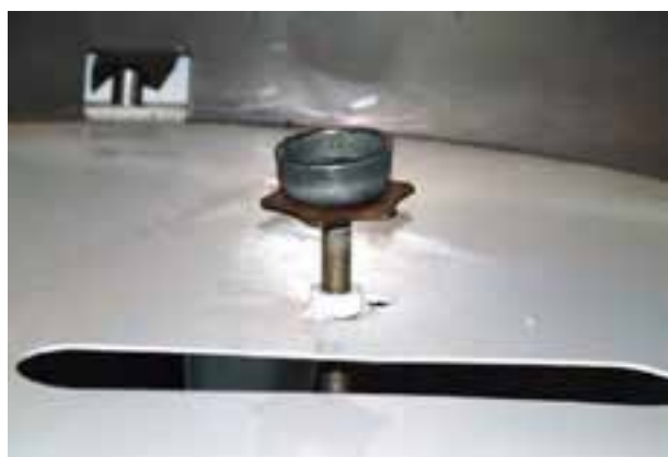
شکل ۹-۱- جک نصب شده بر روی شاسی
