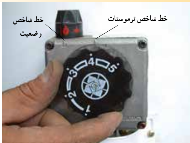
شکل ۱-۱۱۰- تغییر کلید تنظیم دما (ترموستات)
