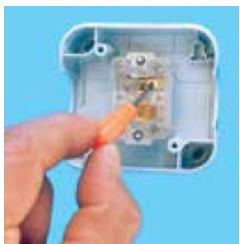
د - برقراری اتصال پلاتین با کنتاكت غیر مشترک ۲
