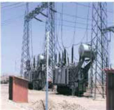
شکل (۲۸-۳) دوترانسفورماتور موازی شده
