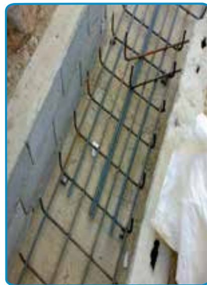
شکل ۱۱-۷- قرار دادن میلگردهای تقویتی
