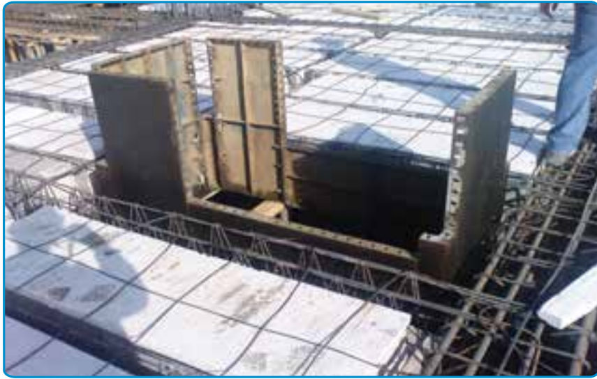
شکل ۳۵-۷- تکمیل قالب بندی
