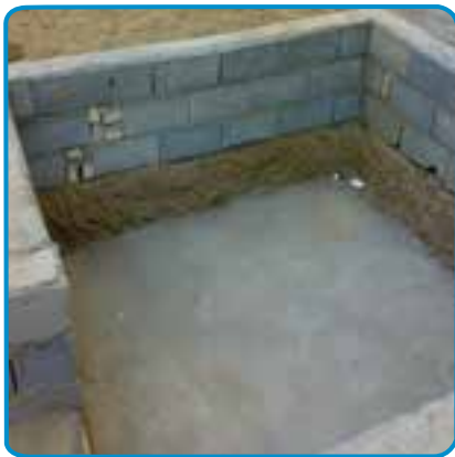
شکل ۱-۷- آماده سازی کف پی
