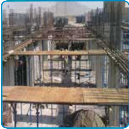
شکل ۷-۲۱- قالب بندی تیرها
