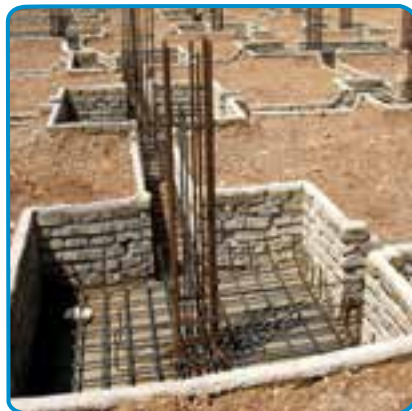
شکل ۴-۷- اجرای میلگردهای ریشه انتظار
