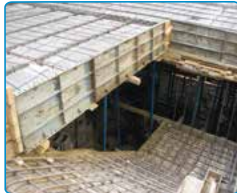
شکل ۴۰-۷- اجرای میلگردهای دال پله
