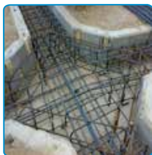
شکل ۱۴-۷- تکمیل میلگردگذاری محل اتصال ستون
