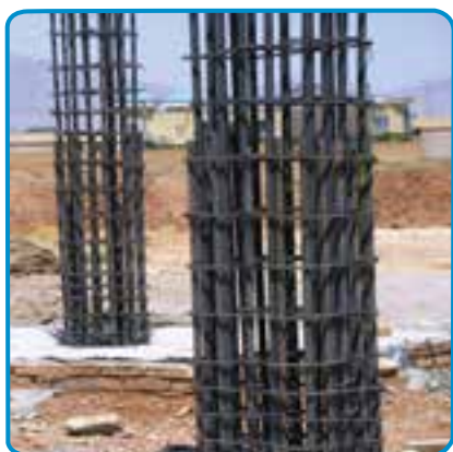
شکل ۱۶-۷- بتن ریزی ستون
