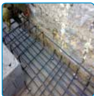
شکل ۱۲-۷- میلگردگذاری شبکه بالای
