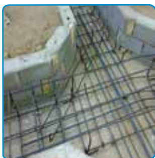
شکل ۱۳-۷- قرار دادن میلگردهای تقویتی پخها
