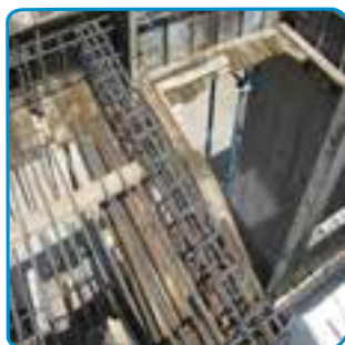
شکل ۳۱-۷-اجرای بازشودر سقف
