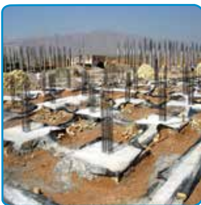
شکل ۱۷-۷- اجرای خاموت و سنجاقک
