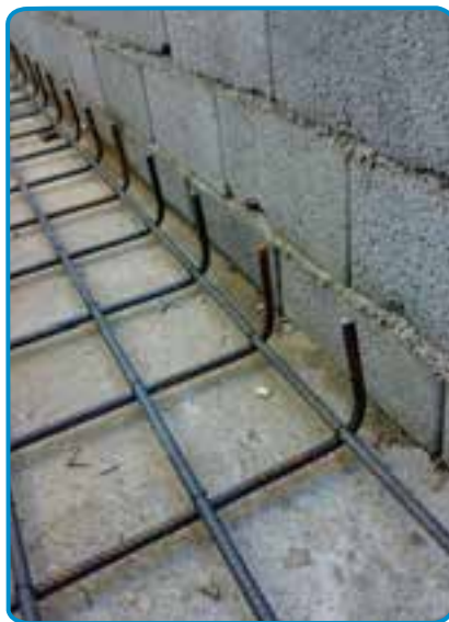
شکل ۱۰-۷- رعایت پوشش بتن در کف و بدنه
