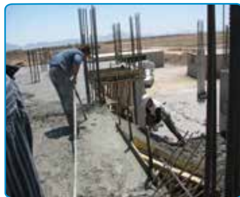
شکل ۴۲-۷- بتن ریزی دال پله
