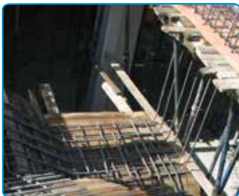
شکل ۴۱-۷- اجرای میلگردهای دال پله
