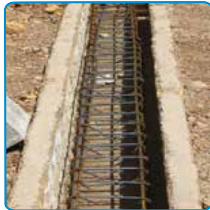
شکل ۵-۷- اجرای میلگرد شناژها
