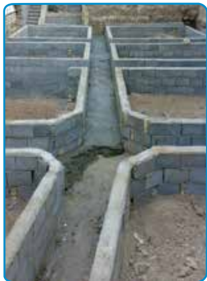
شکل ۶-۷- آماده سازی کف پی
