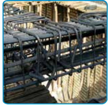
شکل ۷-۲۶- خم میلگردهای اصلی در انتهای محل قرار گیری
