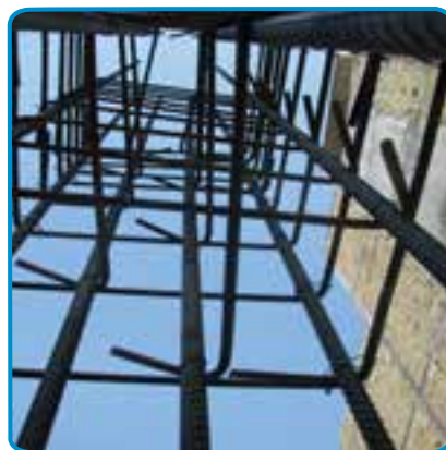
شکل ۱۹-۷- کار گذاشتن میلگردهای انتظار ستون، در فونداسیون
