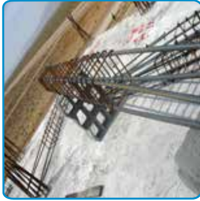
شکل ۷-۲۲- آماده کردن میلگردهای تیر روی زمین
