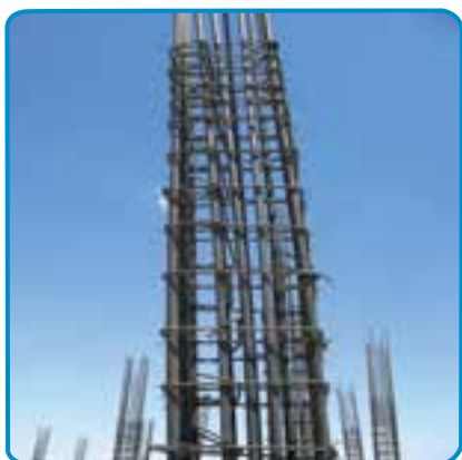
شکل ۱۹-۷- کار گذاشتن میلگردهای انتظار ستون، در فونداسیون
