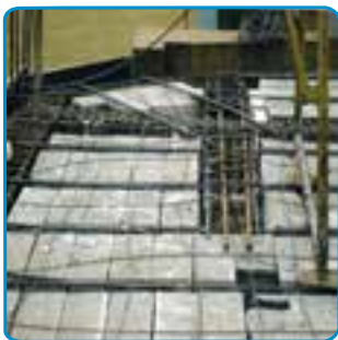
شکل ۳۲-۷-اجرای تیرهای فرعی کنسول
