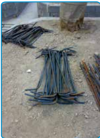
شکل ۷-۷- آماده کردن میلگردهای طولی و عرضی
