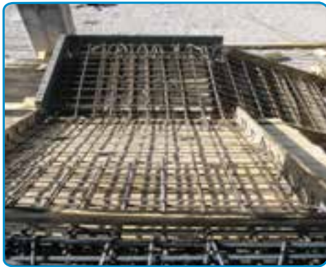
شکل ۳۷-۷- اجرای میلگردهای دال پله
