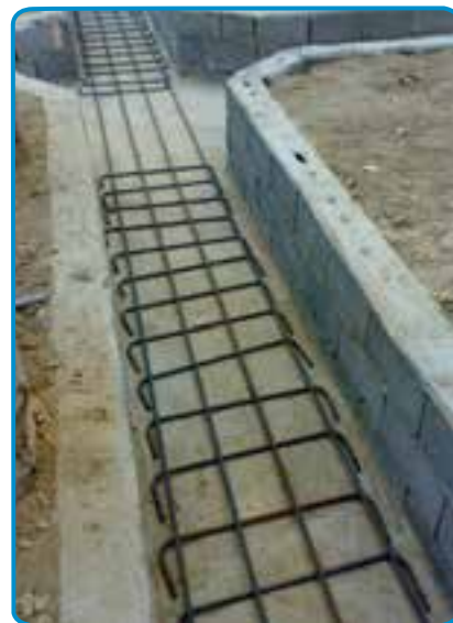
شکل ۸-۷- چیندن میلگردهای طولی و عرضی
