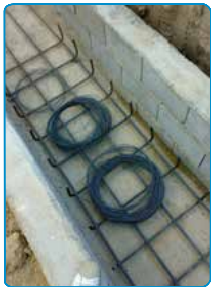
شکل ۹-۷- بهم بستن میلگردها
