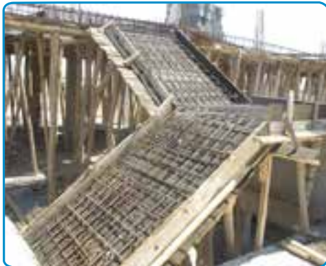
شکل ۳۹-۷- اجرای میلگردهای دال پله
