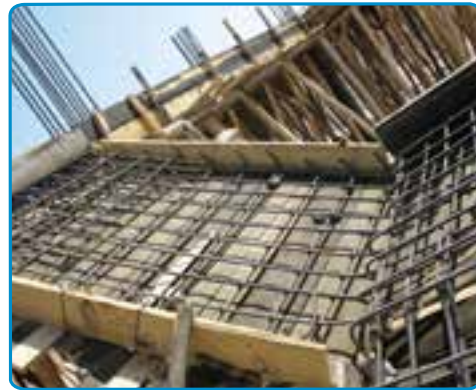
شکل ۳۸-۷- اجرای میلگردهای دال پله
