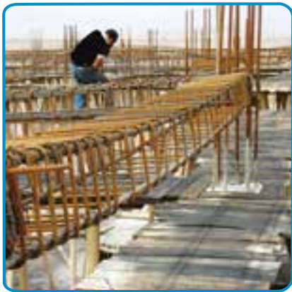
شکل ۷-۲۴- تنظیم فاصله بین خاموت ها
