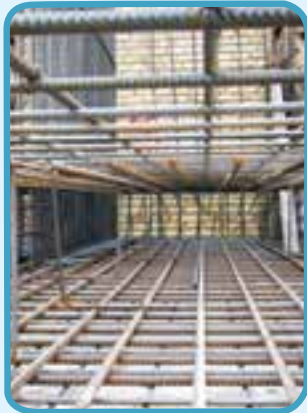
شکل ۱۵-۱- فولاد در بتن
