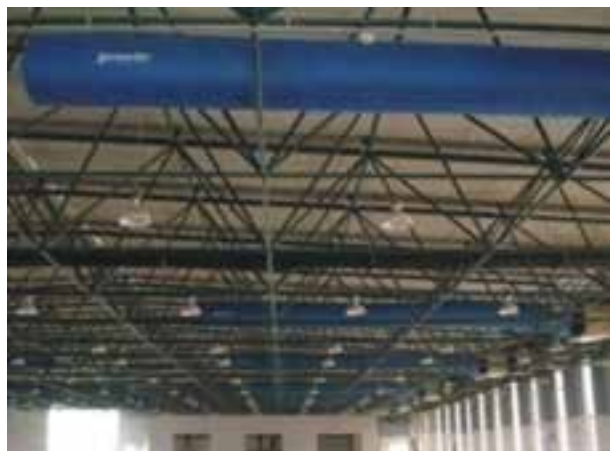
شکل ۳-۷- سقف غیر کاذب
