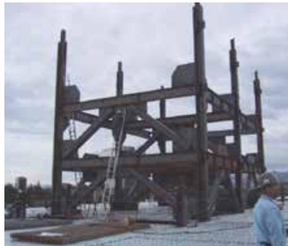
شکل ۳-۸ - تصویر یک سازه‌ی فلزی
