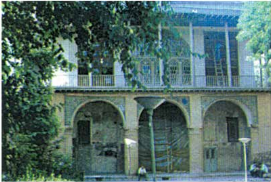
شکل ۱۲۱- عمارت چهلستون قزوین
