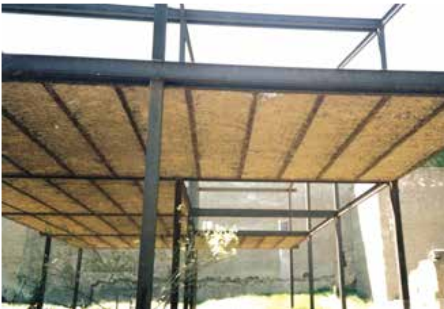
تصویر ۱۰ - تیرریزی سقف طاق ضربی
