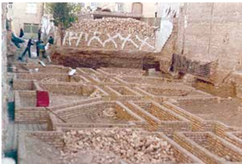
تصویر ۵ - قالب بندی آجری بی ساختمان
