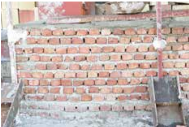
تصویر ۳- قبل از اجرای نماسازی با سنگ باید تراز کردن سطح موردنظر انجام شود.
