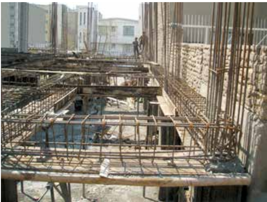
تصویر ۱۲ - نحوه‌ی قرارگیری آرماتورهای کلاف‌های بتنی
