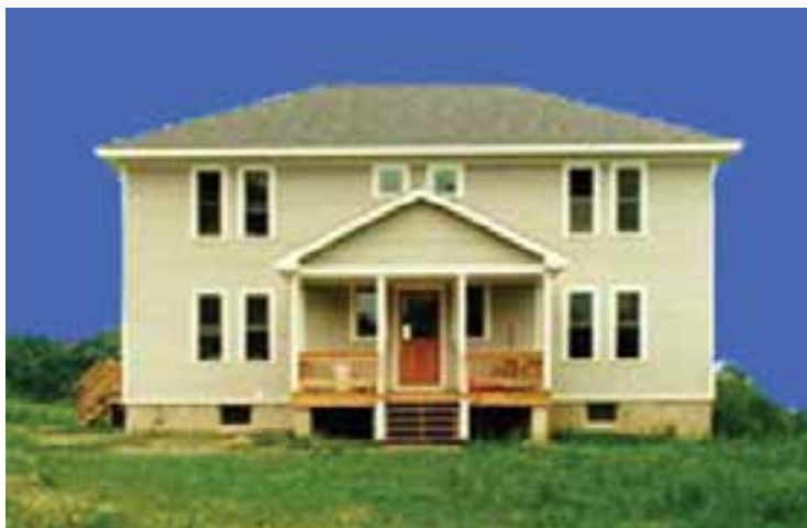
شکل ۱۶-۱- نمای ساختمان اجرا شده
