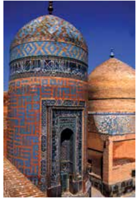
تصویر ۲۴- کوفی بنایی ساده با آجر لعاب دار - بقعه شیخ صفی الدین اردبیلی - دوره صفویه
