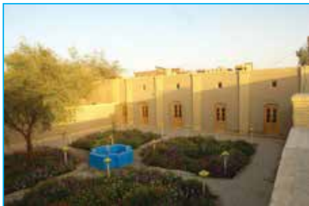
شکل ۱۰-۱۲- ساختمان بیت مقام معظم رهبری
