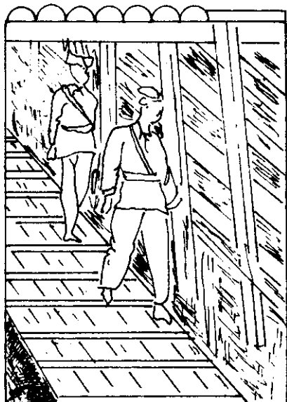
شکل ۶-۱۱- گذرگاه مخصوص کارگران
